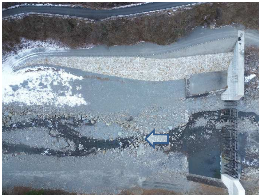
【上空より施工箇所を望む】
