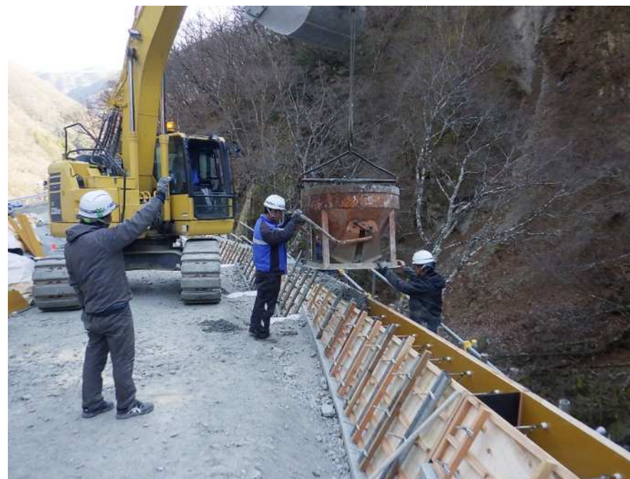
【コンクリート打設状況】
