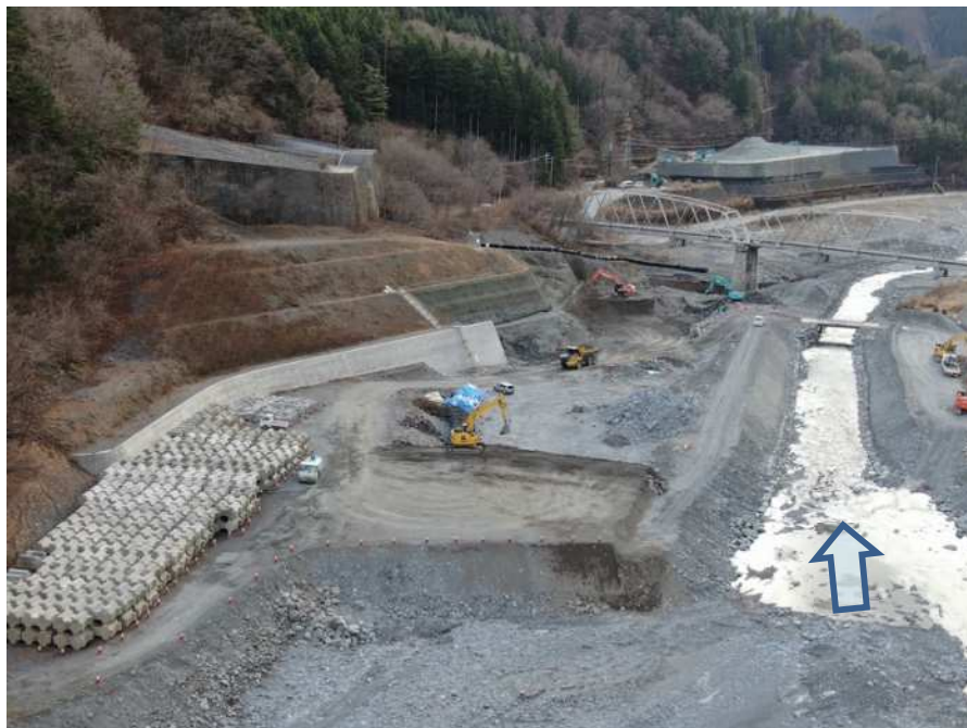
【上流側上空より施工箇所を望む】
