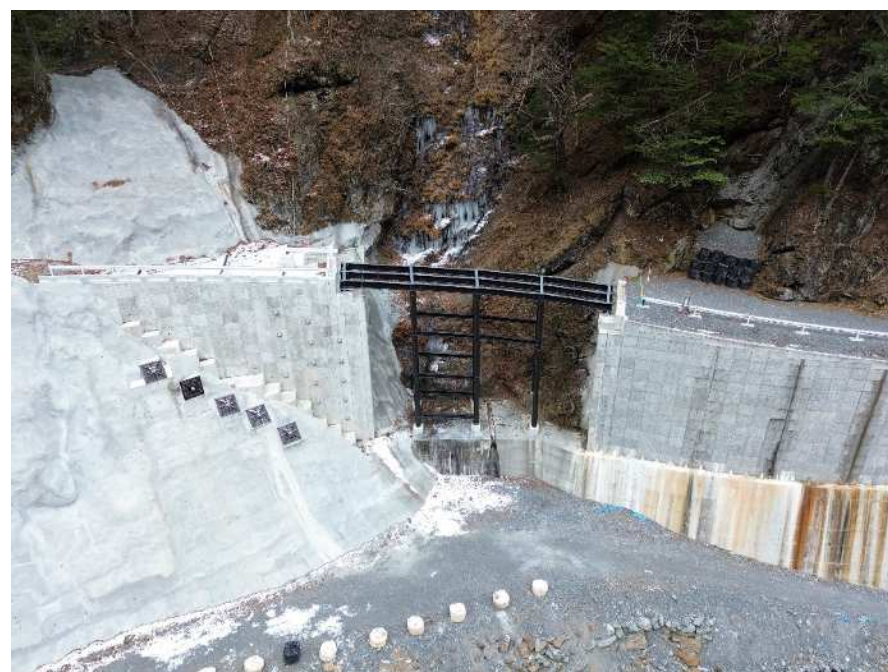
【上空より上部工施工箇所を望む】
