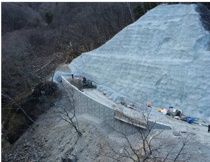
【上空より施工箇所を望む】
