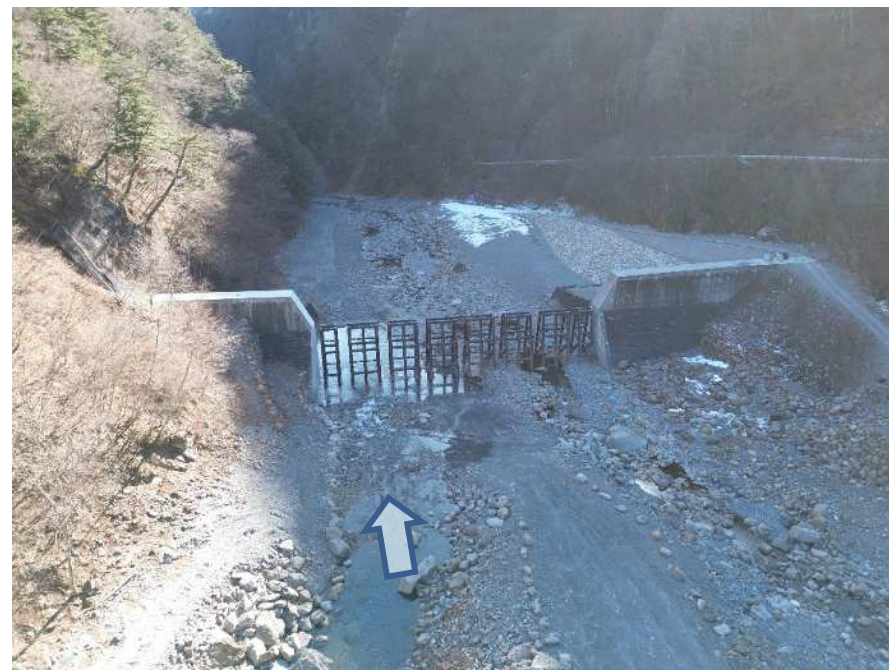
【上流側上空より施工箇所を望む】
