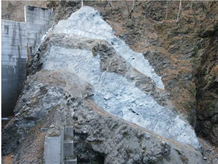
モルタル吹付
