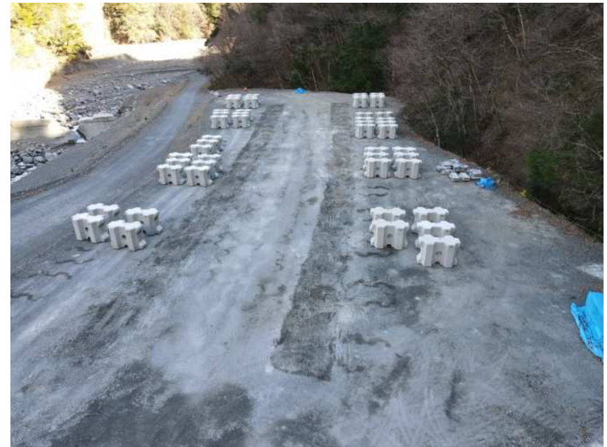
根固ブロック製作
