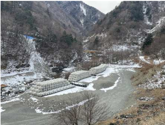
【当初分】根固めブロック工 制作完了
