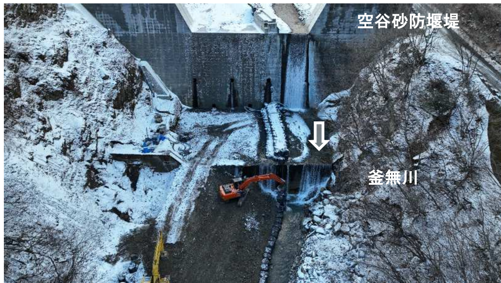
下流より副堰堤を望む
