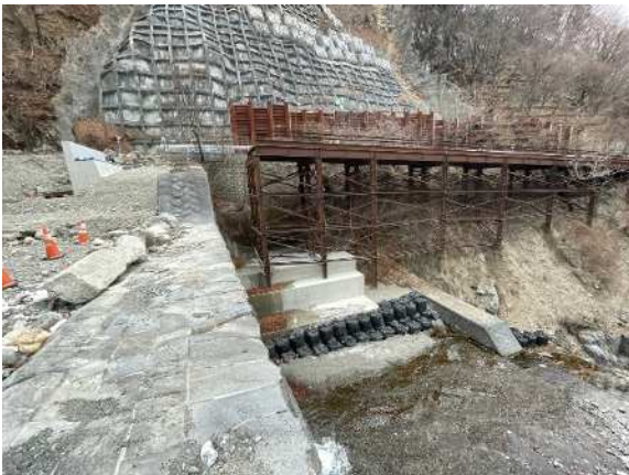
巻立コンクリート工 作業完了
