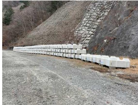
【当初分】根固めブロック工 制作完了
