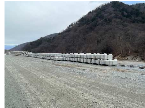
【追加分】根固めブロック工 制作完了
