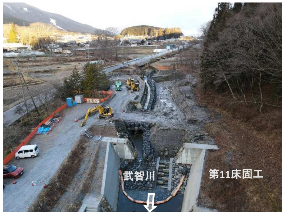
下流上空より施工箇所を望む
