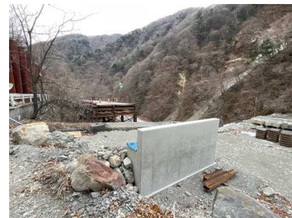
橋台躯体工 コンクリート打設完了
