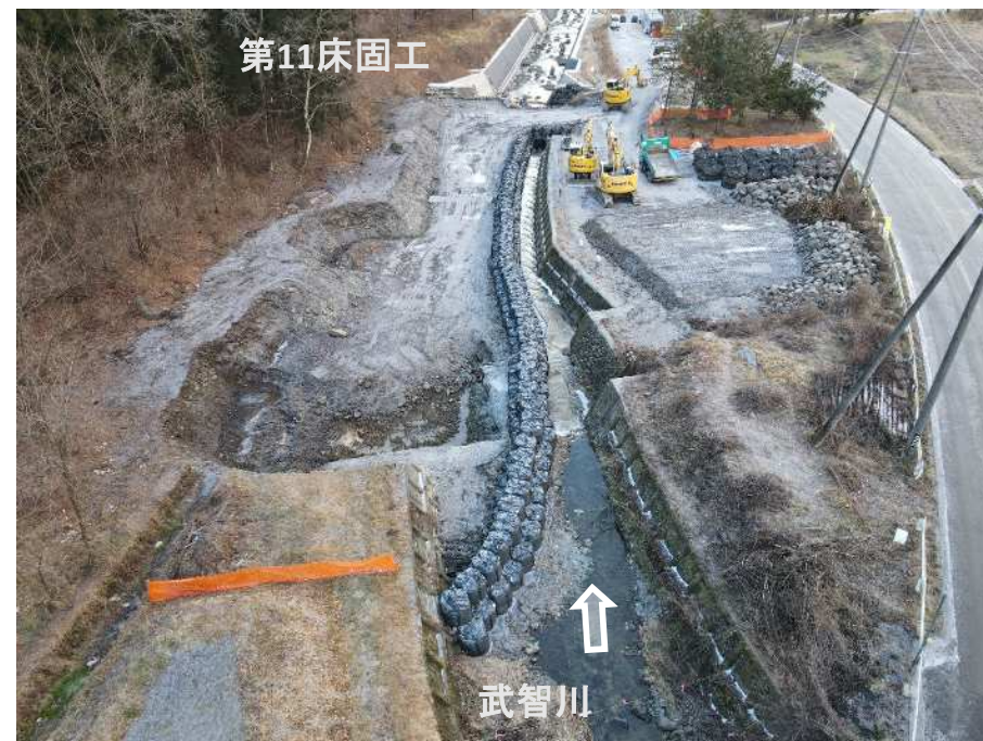
上流上空より施工箇所を望む
