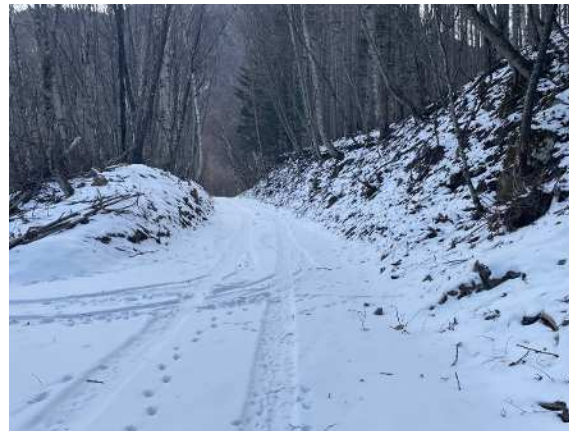
【施工区間②】舗装工 作業完了
