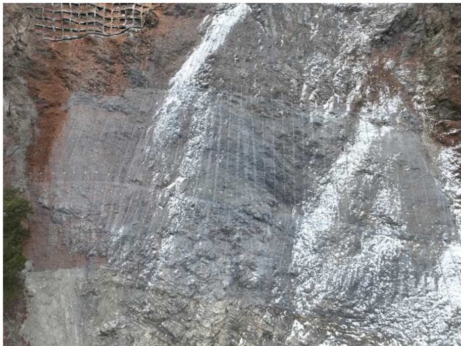
上空より施工箇所を望む
