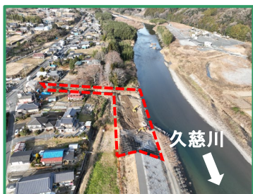
工事箇所の全景（下流から）
