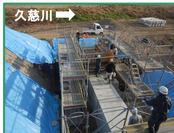
樋管の整備を行っています
