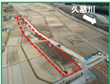
工事箇所の全景（下流から）
