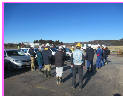
R5久慈川右岸上大賀地先築堤工事でのパトロール状況(12月16日)
