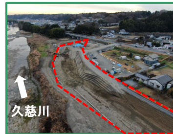
工事箇所の全景（上流から）
