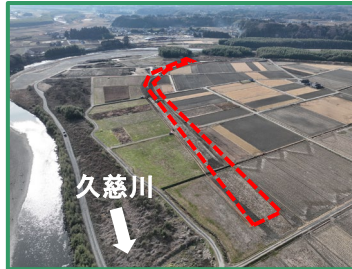
工事箇所の全景（下流から上流へ）
