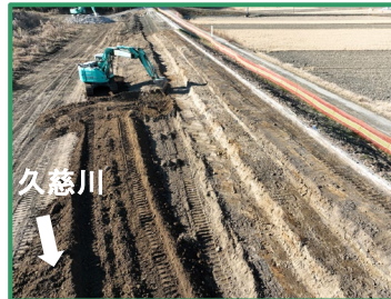
堤防盛土を行っています
