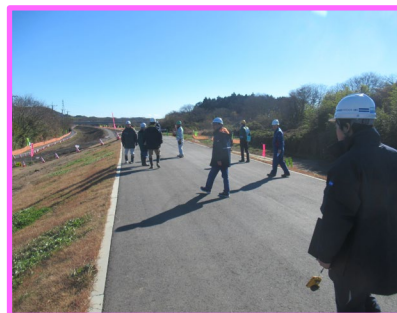
R5久慈川左岸宇留野地先築堤工事でのパトロール状況(12月16日)
