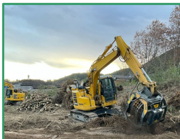
伐採作業を行っています
