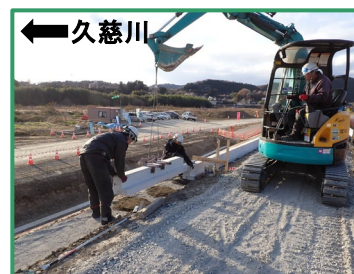
舗装止めブロックを設置しています
