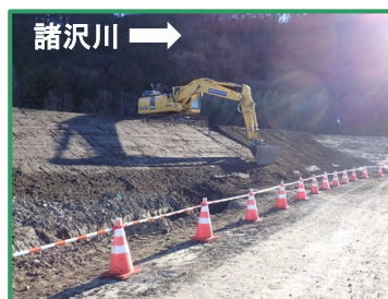
堤防盛土を行っています
