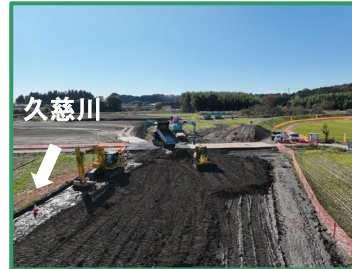
堤防盛土を行っています
