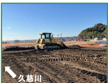
堤防盛土を行っています
