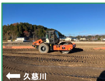
堤防盛土を行っています
