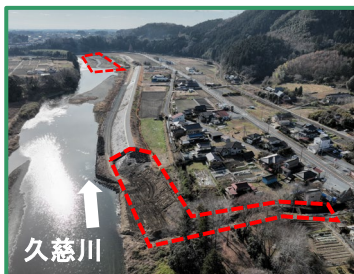
工事箇所の全景（上流から）
