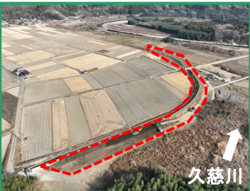
工事箇所の全景（上流から下流へ）
