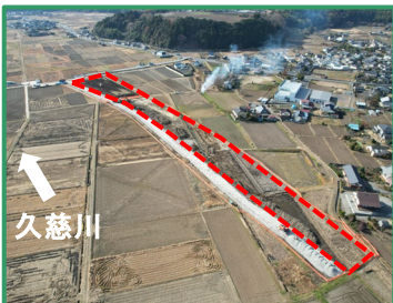
工事箇所の全景（下流から）
