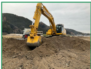
河道掘削を行っています
