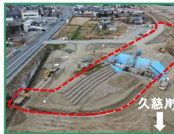
工事箇所の全景（下流から）
