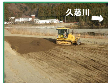
堤防盛土を行っています
