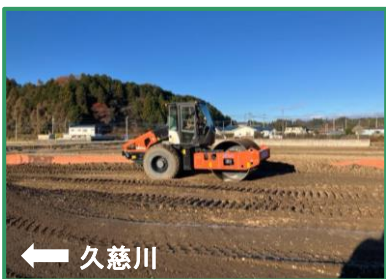
堤防盛土を行っています
