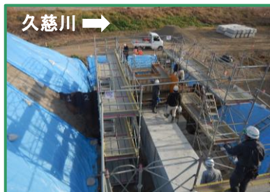
樋管の整備を行っています
