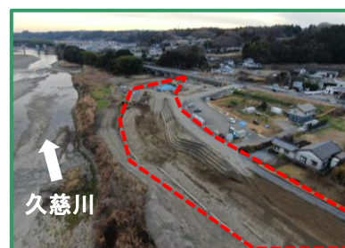
工事箇所の全景（上流から）
