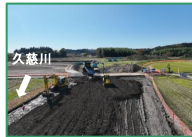
堤防盛土を行っています
