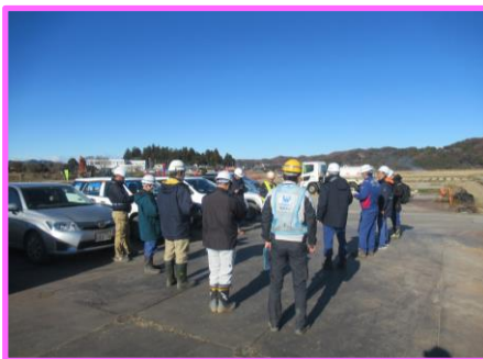
R5久慈川右岸上大賀地先築堤工事でのパトロール状況(12月16日)
