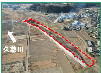
工事箇所の全景（下流から）
