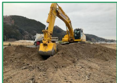
河道掘削を行っています
