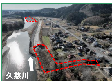
工事箇所の全景（上流から）
