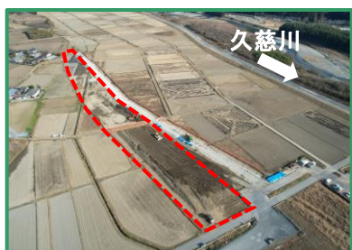
工事箇所の全景（下流から）
