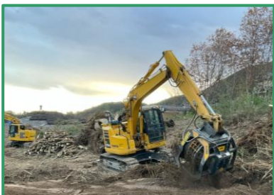
伐採作業を行っています
