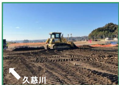
堤防盛土を行っています
