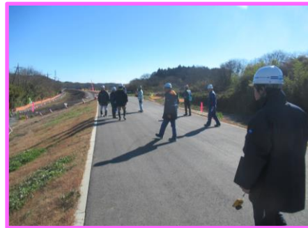
R5久慈川左岸宇留野地先築堤工事でのパトロール状況(12月16日)
