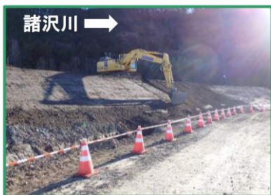
堤防盛土を行っています
