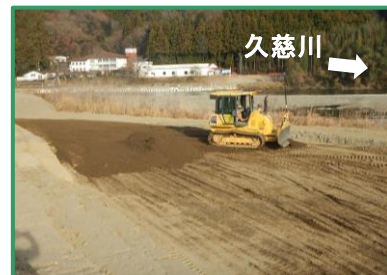
堤防盛土を行っています
