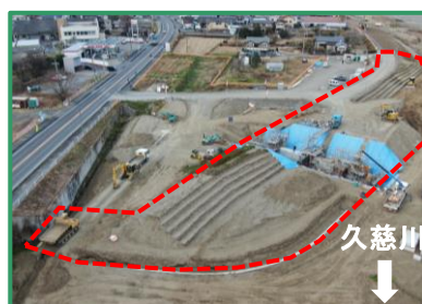
工事箇所の全景（下流から）
