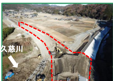
工事箇所の全景（下流から）
