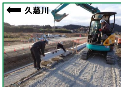
舗装止めブロックを設置しています
