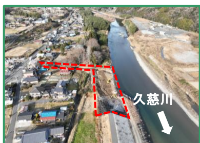
工事箇所の全景（下流から）
