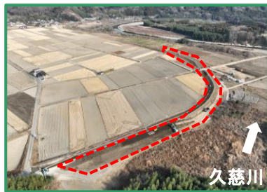
工事箇所の全景（上流から下流へ）
