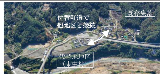
横壁地区の移転状況
