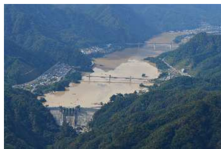
10月17日 ダム貯留状況
