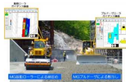
GNSS締固めシステム概念図
