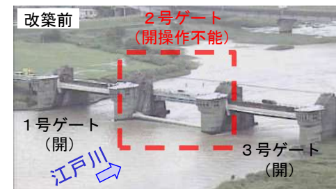
ゲート開操作不能状況 (平成19年台風第9号)
