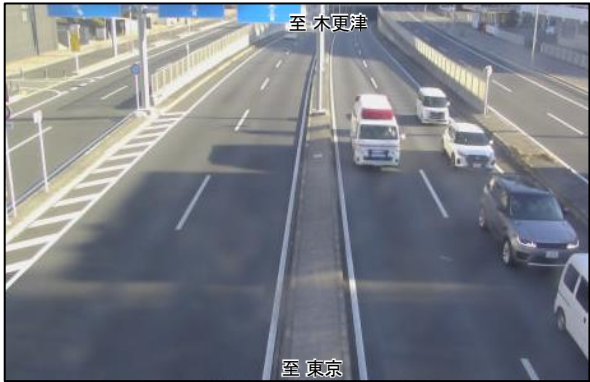
② 国道357号地下立体部
