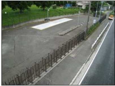
◎ 事前待機箇所(狭山特車基地(大宮国道))
