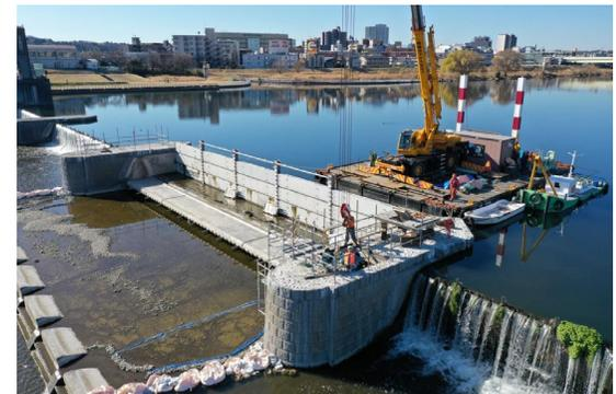
修繕にあたり油圧シリンダ等の搬入にクレーンが必要となることから、水面に台船を設置します
