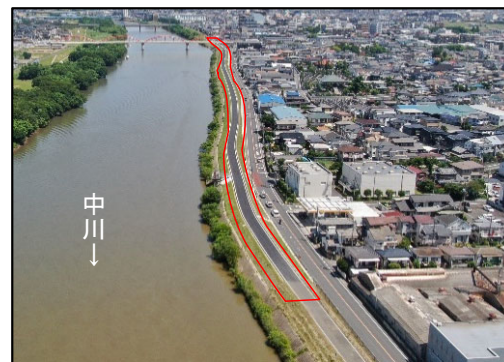
堤防整備(埼玉県吉川市) よしかわし
