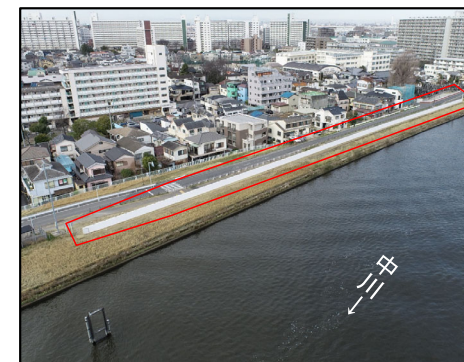
堤防整備(東京都足立区) あだちく
