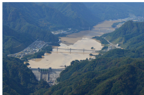
10月17日 ダム貯留状況
