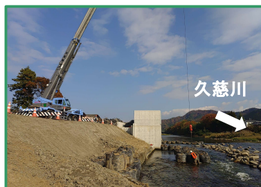
仮締切を設置しています
