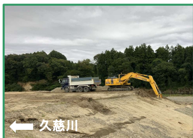
河道掘削を行っています
