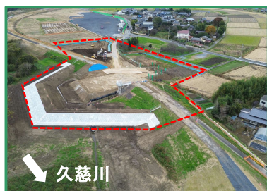
工事箇所の全景（下流から）
