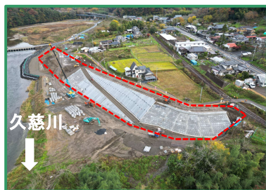
工事箇所の全景（下流から）
