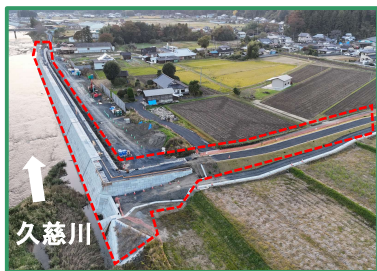
工事箇所の全景（上流から）
