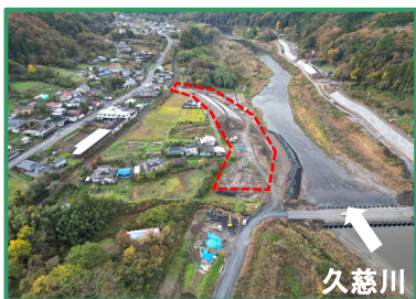
工事箇所の全景（上流から）
