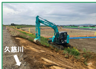
堤防の整備を行っています
