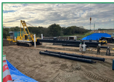
地盤改良機の組立を行っています
