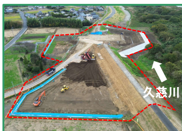
工事箇所の全景（上流から）
