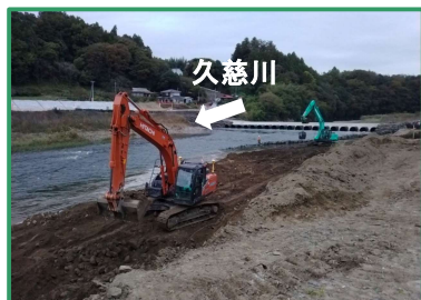
仮締切を設置しています
