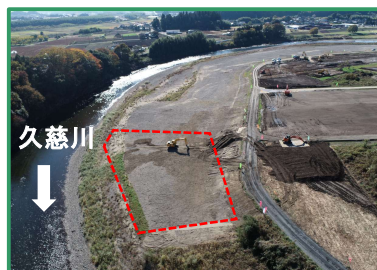
小貫地区の河道掘削を行っています
