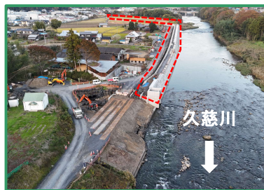
工事箇所の全景（下流から）
