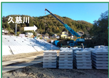
コンクリートブロック張を行っています
