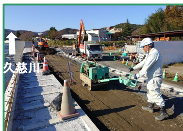
堤防の整備を行っています
