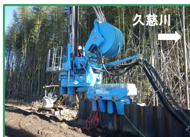
鋼矢板の打設を行っています
