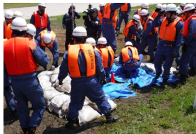
水防団による訓練 （月の輪工）
