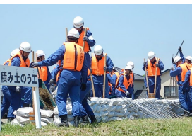
水防団による訓練 （積み土のう工）
