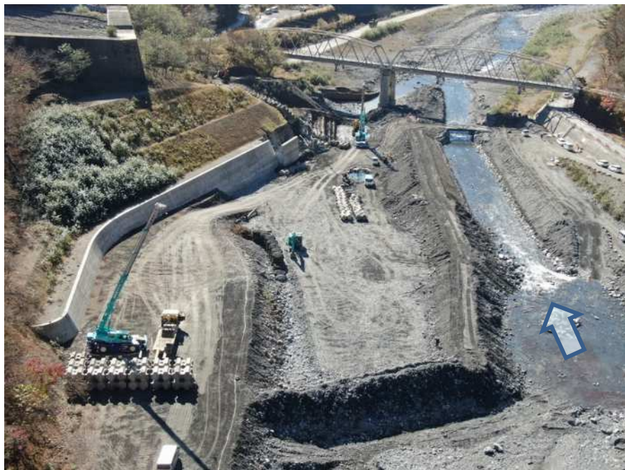
【上流側上空より施工箇所を望む】
