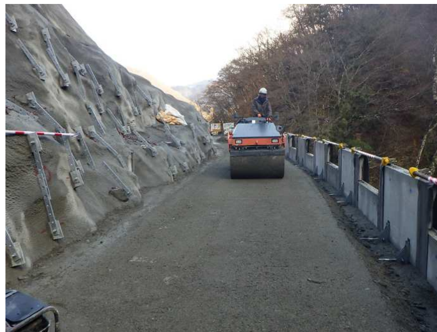
【補強土壁工施工状況】
