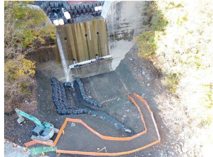
小春木水叩施工
