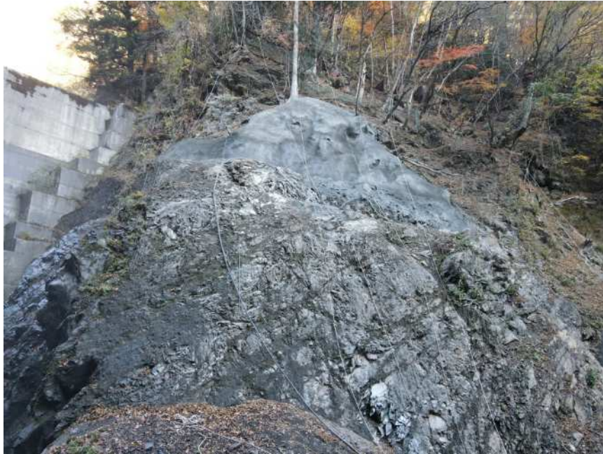
モルタル吹付
