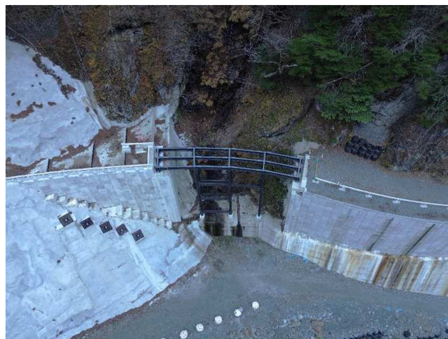
【上空より上部工施工箇所を望む】
