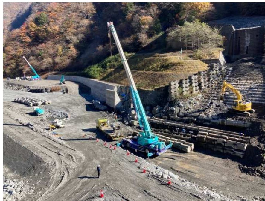
【根固めブロック撤去状況】
