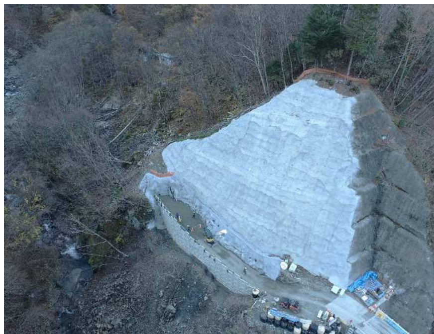
【下流側上空より施工箇所を望む】
