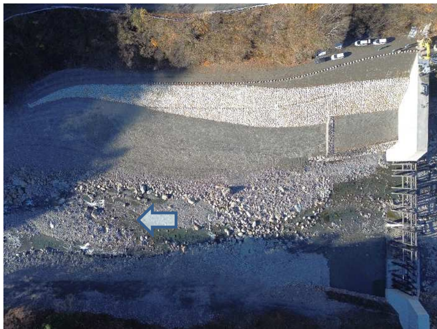
【上空より施工箇所を望む】
