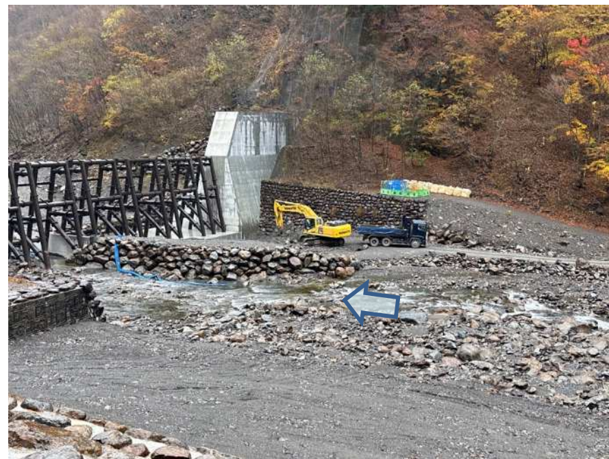
【仮締切撤去 場内整備状況】
