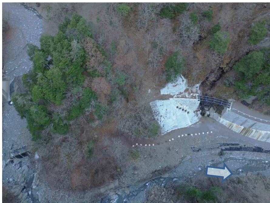
【上空より施工箇所全体を望む】
