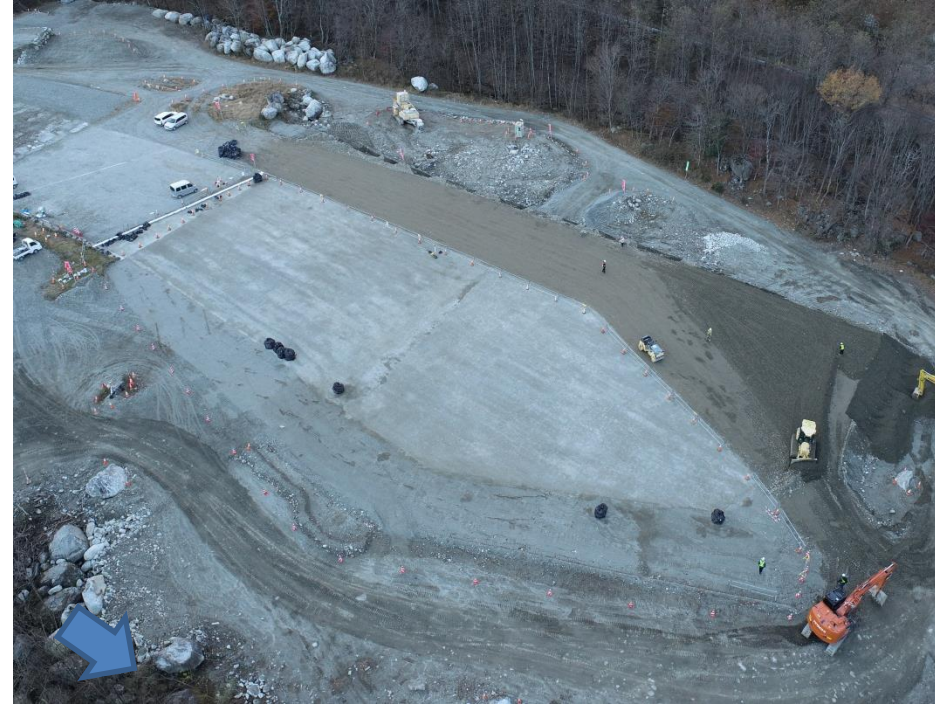
・導流堤工 築堤盛土工【土砂】 ・砂防土工 法面整形工
