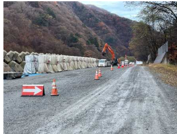
【追加分】根固めブロック工 制作
