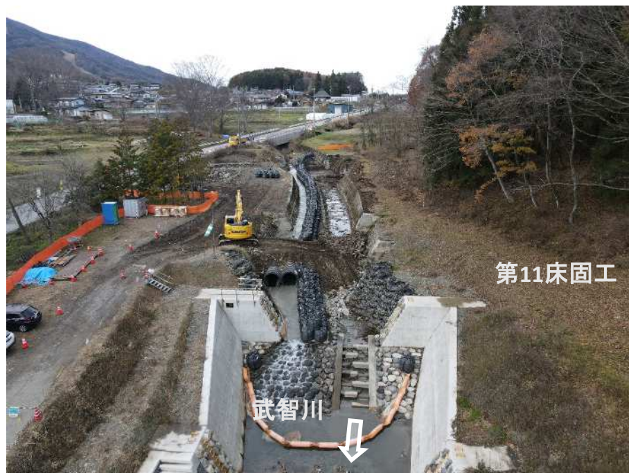
下流上空より施工箇所を望む
