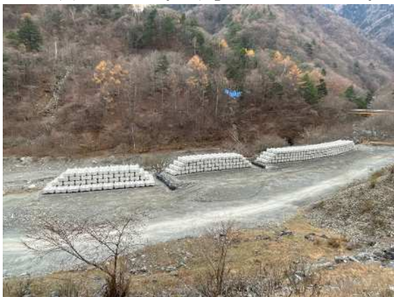
【当初分】根固めブロック工 制作完了
