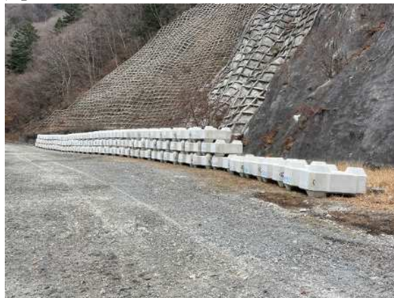
【当初分】根固めブロック工 制作完了
