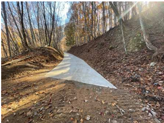
舗装工 施工区間② コンクリート舗装工 作業完了
