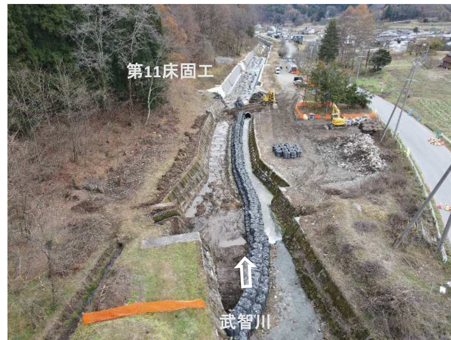
上流上空より施工箇所を望む
