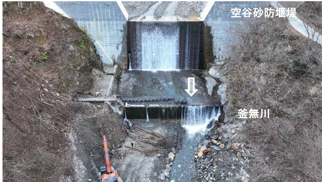
下流より副堰堤を望む
