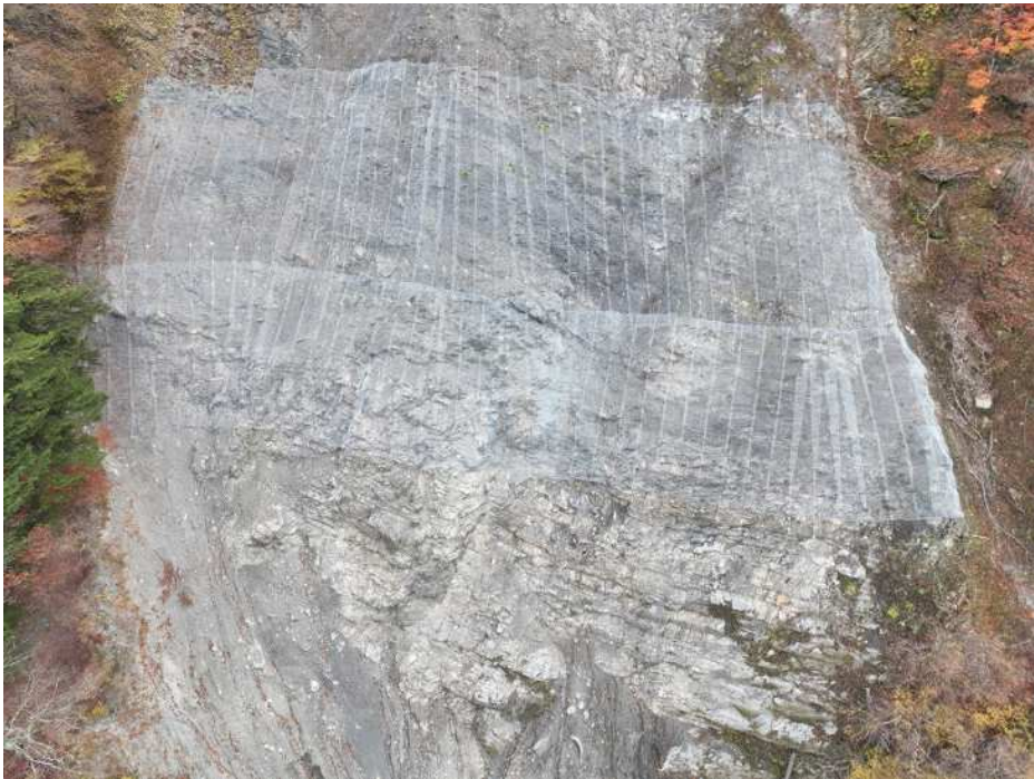
上空より施工箇所を望む
