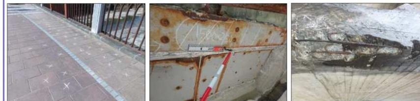
[橋面タイルの浮き] [補強鋼板の浮き・腐食] [アーチリブの剥離・鉄筋露出]
