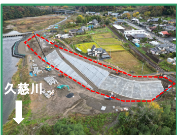
工事箇所の全景（下流から）
