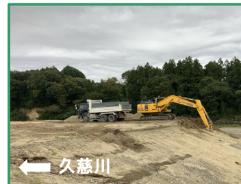
河道掘削を行っています
