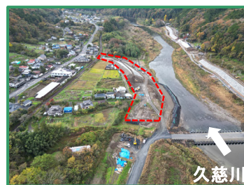
工事箇所の全景（上流から）
