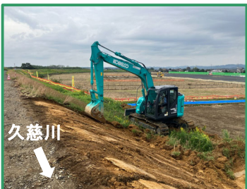
堤防の整備を行っています
