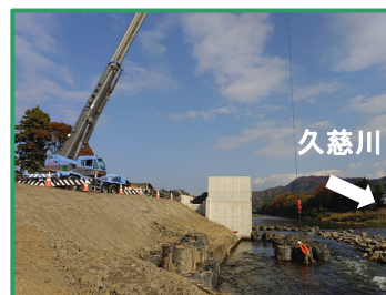
仮締切を設置しています
