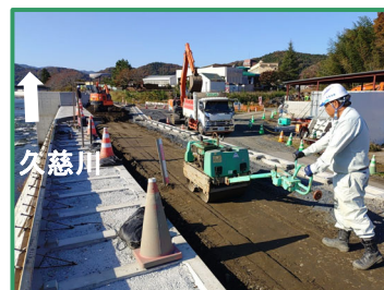
堤防の整備を行っています
