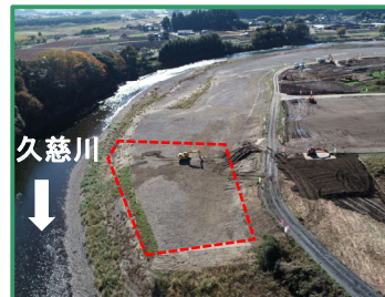
小貫地区の河道掘削を行っています
