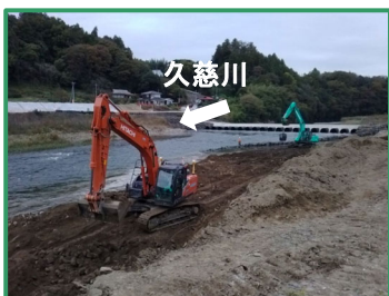
仮締切を設置しています
