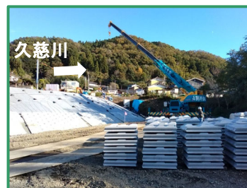
コンクリートブロック張を行っています
