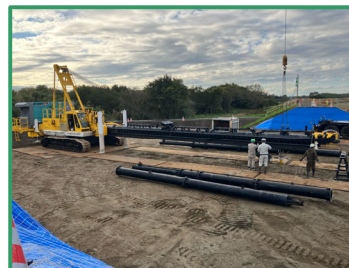
地盤改良機の組立を行っています
