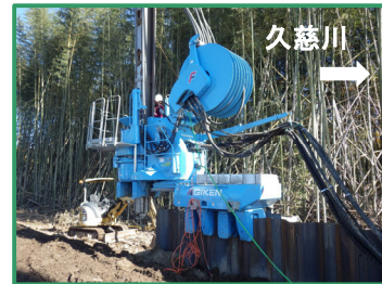
鋼矢板の打設を行っています
