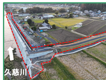
工事箇所の全景（上流から）
