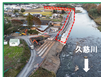
工事箇所の全景（下流から）
