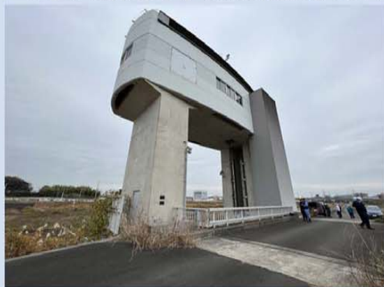
【遊水地排水門】
