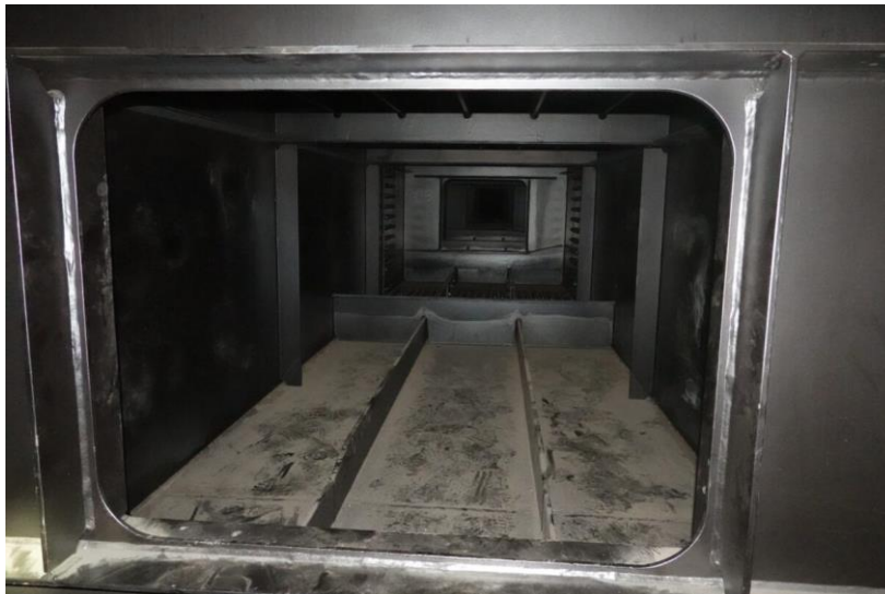
橋梁箱桁内部
