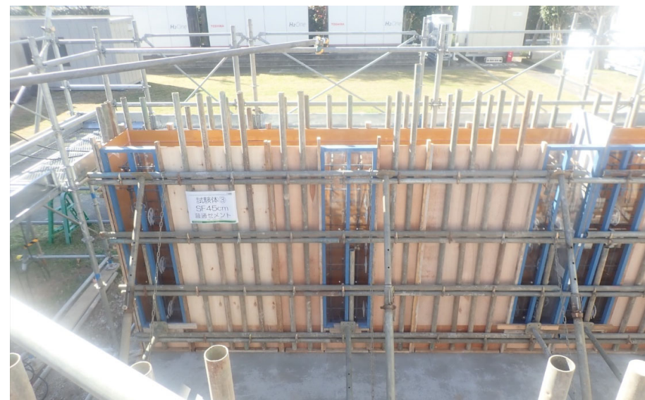
実験前(鉄筋・型枠組立完了)の状況
