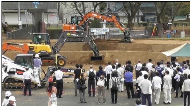
**ICT施工現場展示エリア**では、小規模工事に適したICT建機を活用した盛土工を実演
