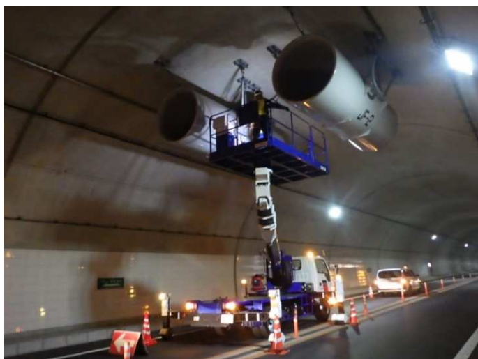
高所作業車によるトンネル設備点検のイメージ写真 中部横断自動車道の点検時の写真です。
