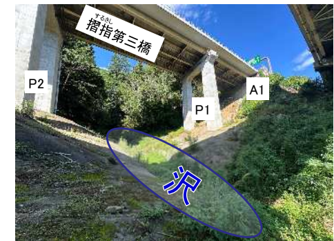
〔摺指第三橋〕写真:2024年6月 急峻な谷地形での工事用進入路整備を計画
