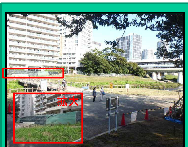
工事着手前(令和2年9月撮影)
