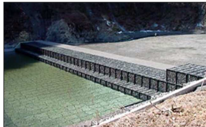
鋼製自在枠形式による貯砂ダムの設置事例
