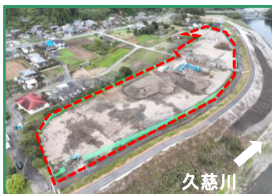
工事箇所の全景（上流から）
