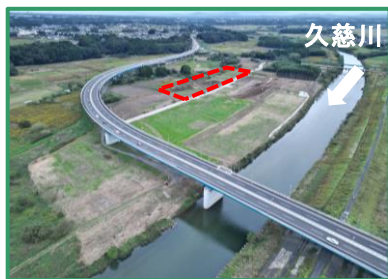
工事箇所の全景（下流から）
