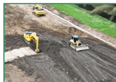
堤防盛土を行っています
