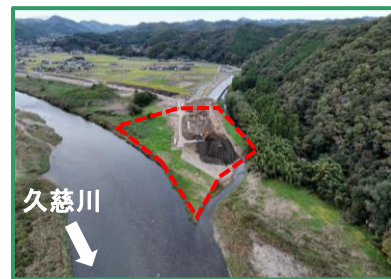
工事箇所の作業中全景（下流から）
