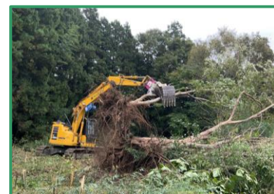
伐採作業を行っています
