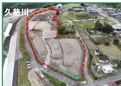
工事箇所の全景（下流から）
