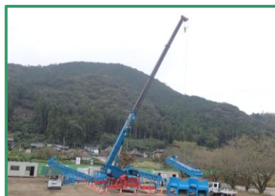
土砂改良機の設置を行っています
