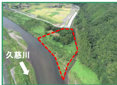
工事箇所の作業前全景（下流から）
