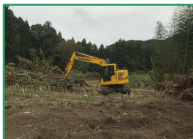
伐採作業を行っています
