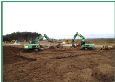
伐採作業を行っています
