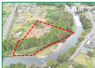
工事箇所の全景（下流から）
