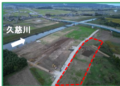
工事箇所の全景（上流から）
