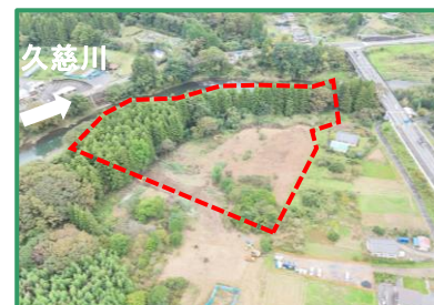
工事箇所の全景（上流から）
