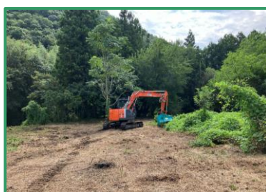
伐採作業を行っています
