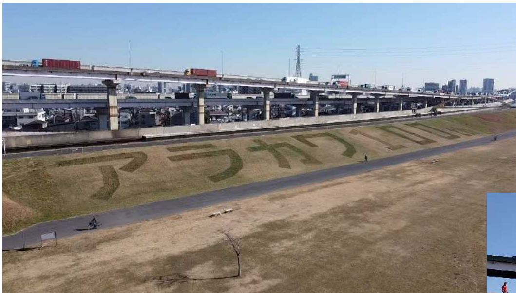
R5小名木川管内左岸維持管理工事
