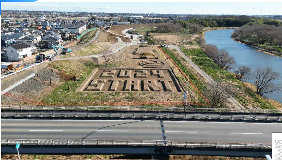
R4入間川左岸釘無河道掘削他工事
