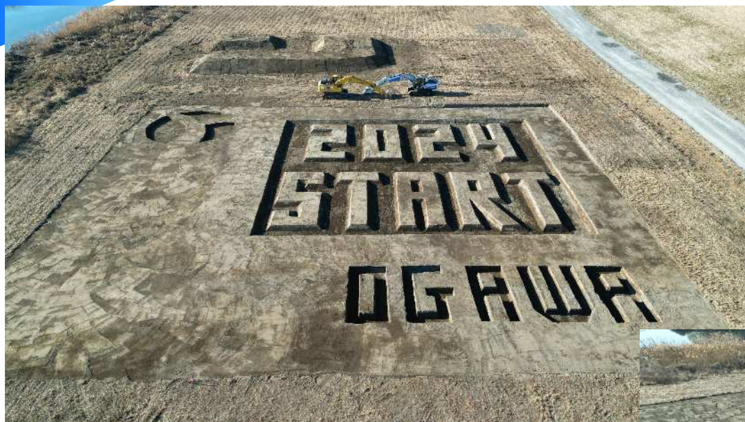
R4利根川右岸栗橋北堤防強化工事
