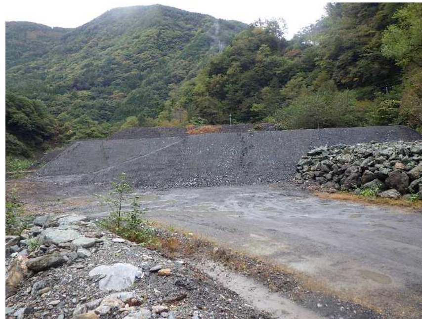
残土処理完了
