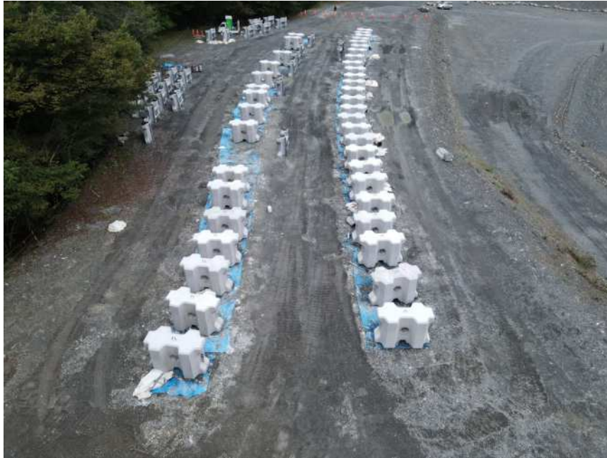
根固ブロック製作中
