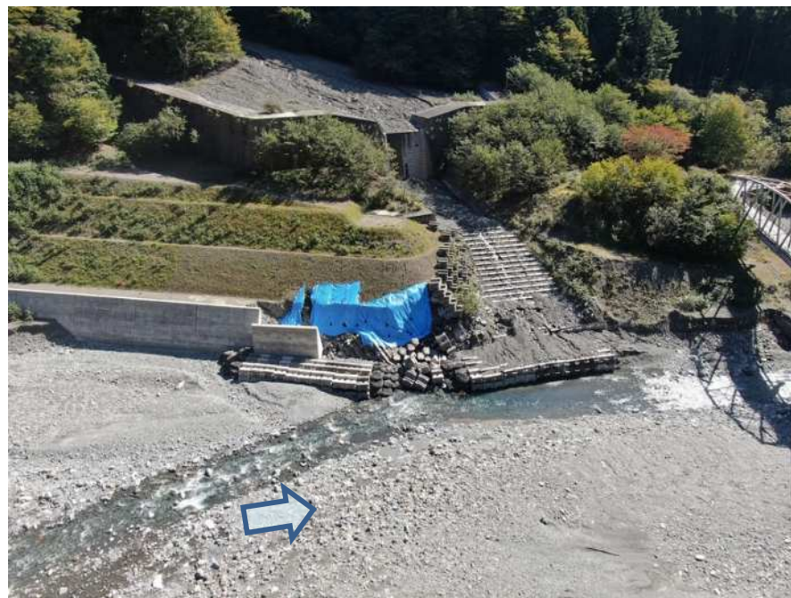
【右岸側上空より施工箇所を望む】
