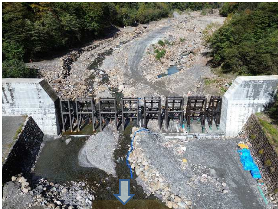
【下流側上空より施工箇所を望む】
