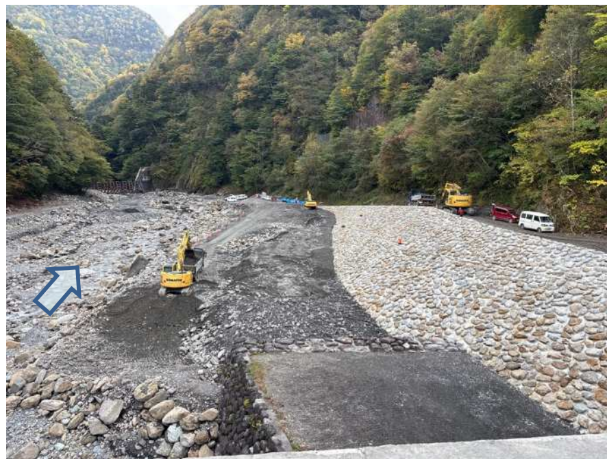
【第三砂防堰堤より管理用道路施工箇所を望む】
