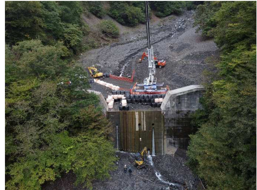
小春木仮設備整備
