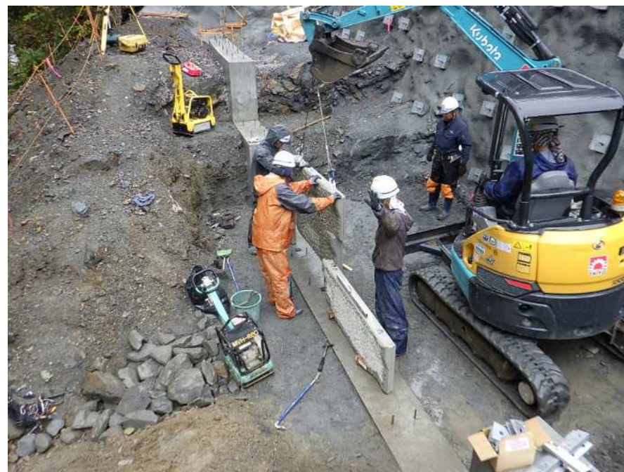
【補強土壁工施工状況】
