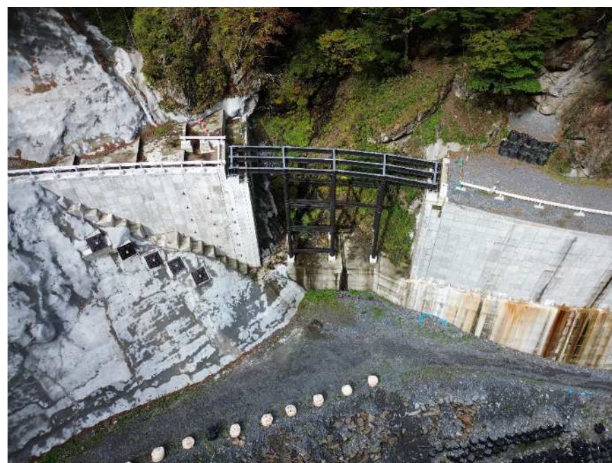
【上空より上部工施工箇所を望む】
