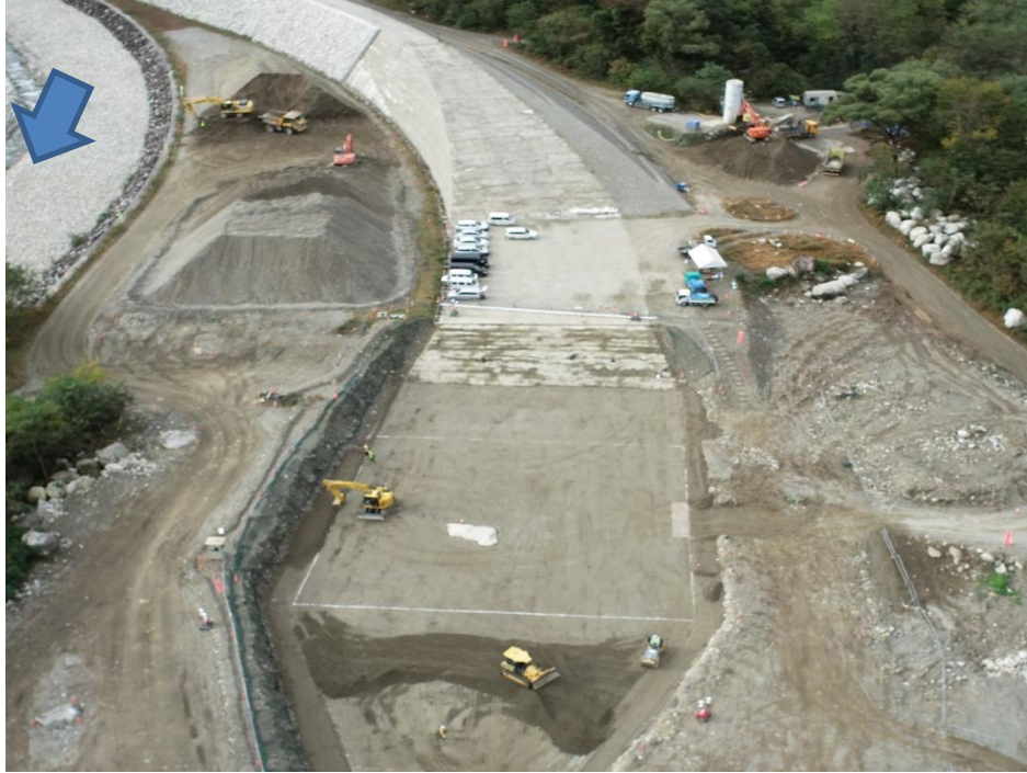
導流堤工 築堤盛土工【砂防ソイルセメント】 路体(築堤)盛土
