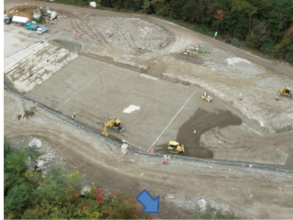
導流堤工 築堤盛土工【砂防ソイルセメント】 路体(築堤)盛土
