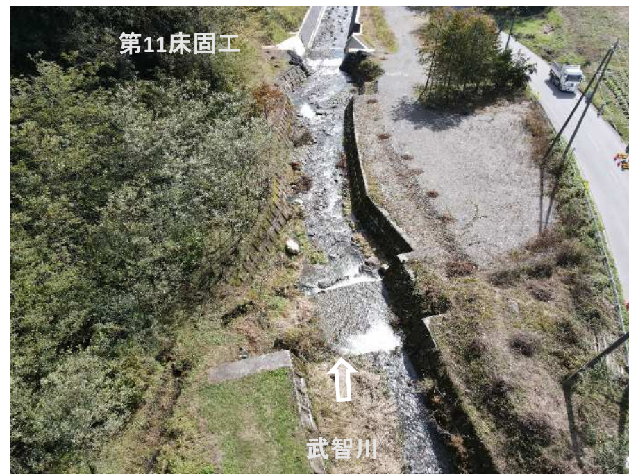
上流上空より施工箇所を望む
