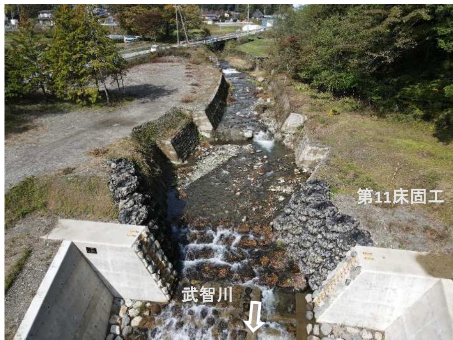
下流上空より施工箇所を望む
