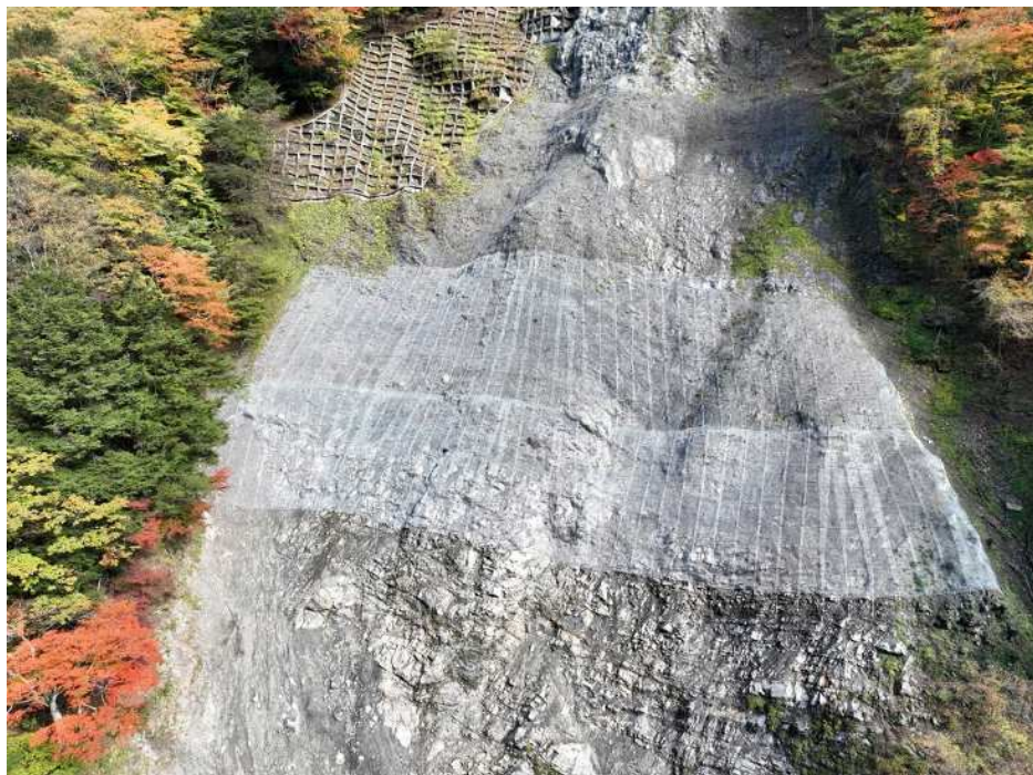
上空より施工箇所を望む
