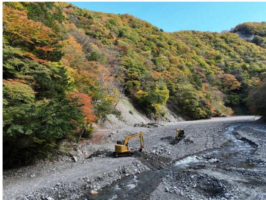
仮設工 作業ヤード整備工 整地
