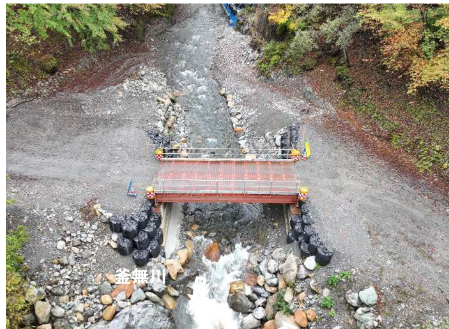
仮設工 仮橋・仮栈橋工 設置完了 (副堰堤下流側 工事用道路)
