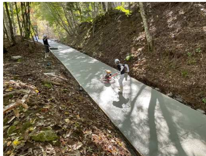
コンクリート舗装工 施工区間②
