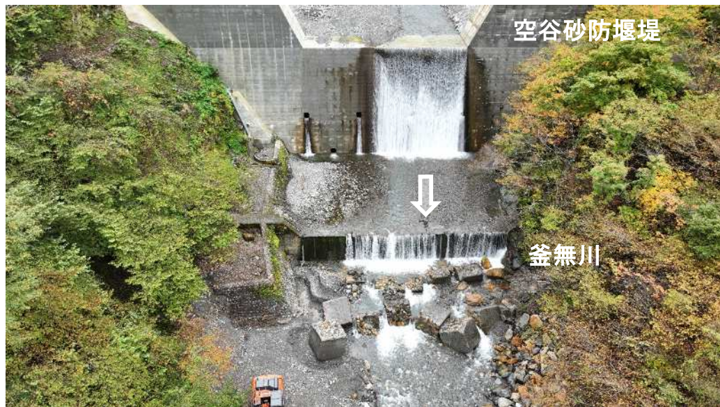
【着手前】下流より副堰堤を望む
