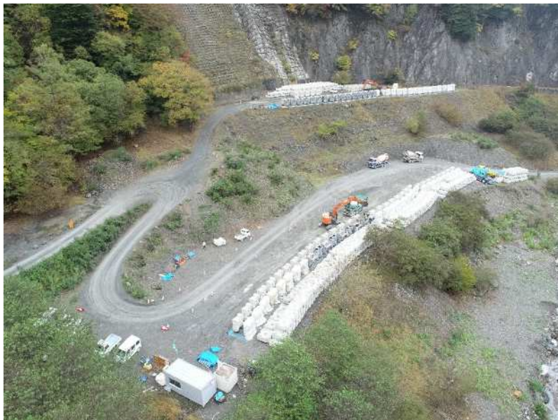
根固めブロック工 制作
