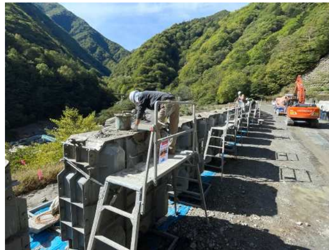
根固めブロック工 制作
