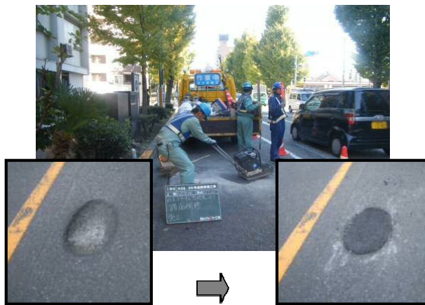
〈ポットホール補修〉
