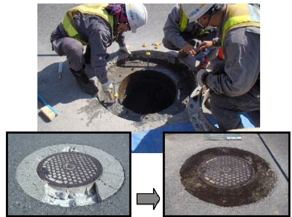
〈マンホール補修〉
