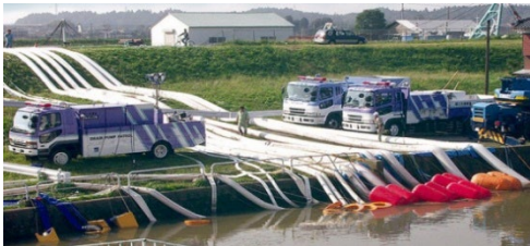
排水ポンプ車による排水活動
