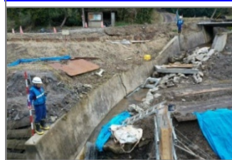
調査箇所：石川県輪島市 中田川
