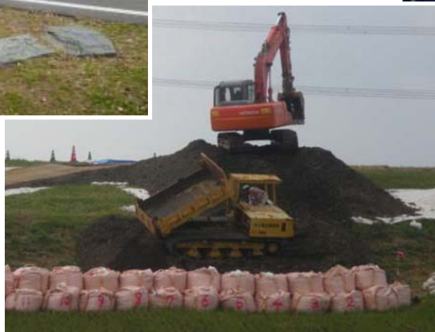
建設業者による水防支援 (イメージ)
