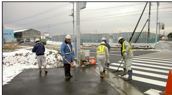
〈歩道除雪 通学路〉
