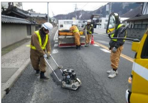
〈路面補修（ポットホール）〉
