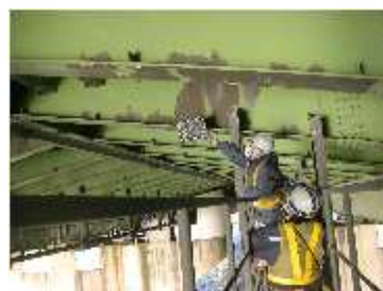
<橋梁点検（横桁）>
