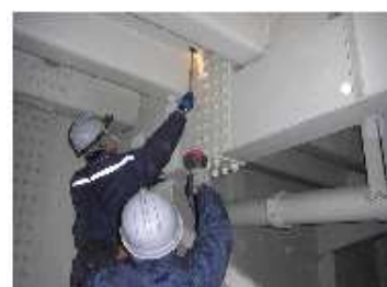
<橋梁点検（鋼床版）>
