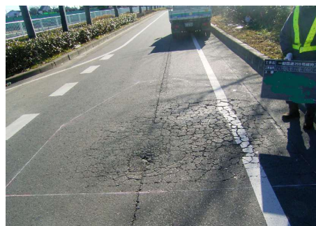
<路面異状確認>
