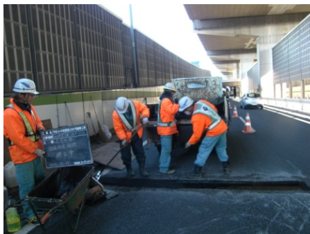
<路面段差補修>
