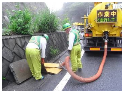
〈側溝清掃（機械）〉
