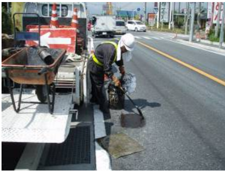
〈路面補修〉（ポットホール）
