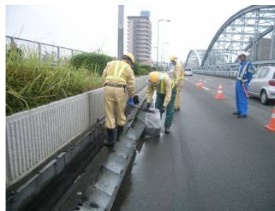
〈側溝清掃（人力）〉
