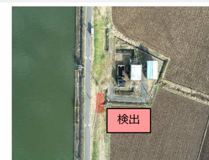
AIによる変状の自動抽出 (背面の陥没)
