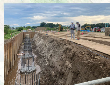
デジタル野帳を用いた 現場打合せ状況
