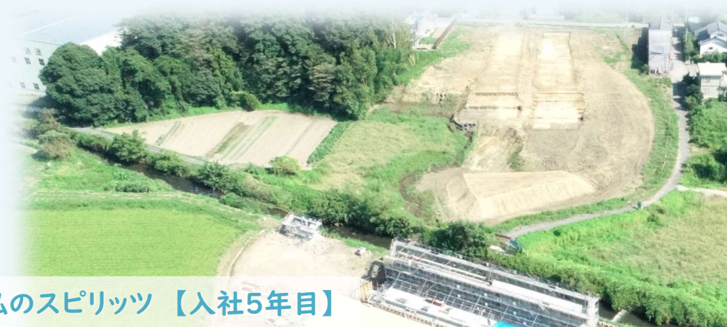
本線橋 AI橋台 底版打設状況
