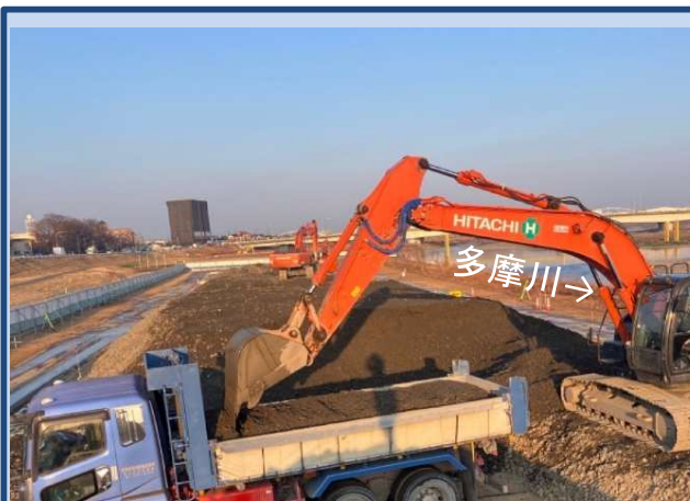
土砂の積込み・運搬を行っています。 (令和7年1月)
