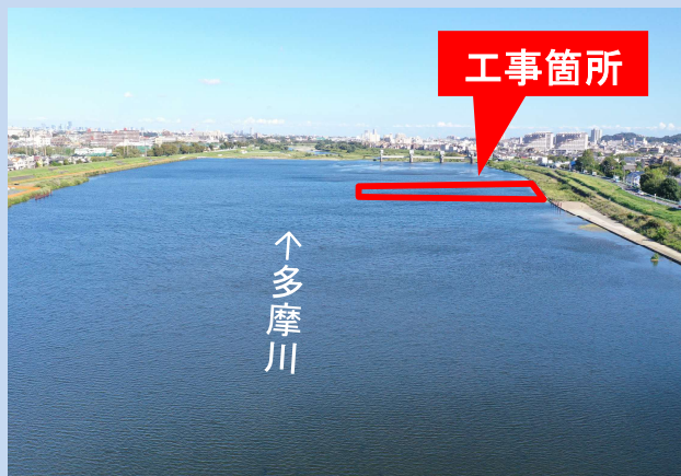
工事着手前 (令和6年9月)
