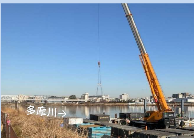
台船を解体しています。 (令和7年2月)
