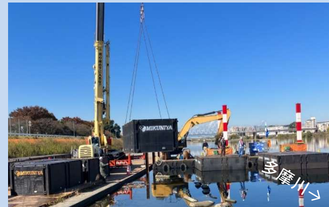
作業船の組立を行っています。 (令和6年11月)
