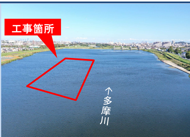
工事着手前 (令和6年9月)
