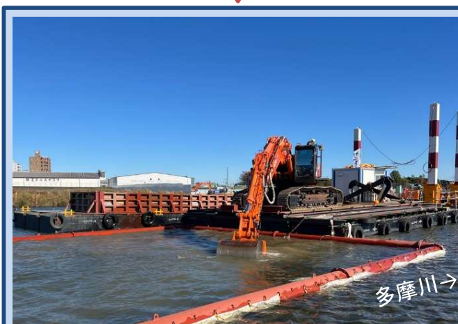
河道を浚渫しています。 (令和6年12月)
