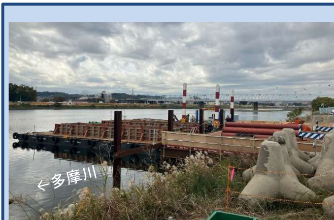
作業船の組立を行っています。 (令和6年11月)
