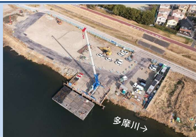
台船を解体しています。 (令和7年2月)
