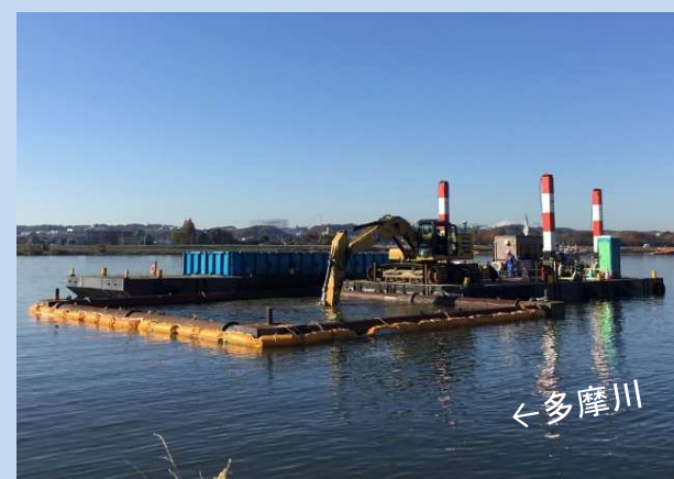
河道を浚渫しています。 (令和6年12月)
