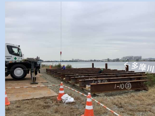
栈橋を設置しています。 (令和6年11月)
