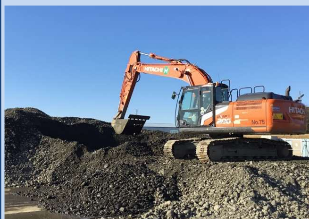
土砂のふるい分けを行っています。 (令和7年1月)
