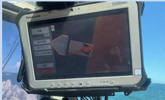
クレーン運転席のモニターで打設位置を確認しながらのICT施工です。
