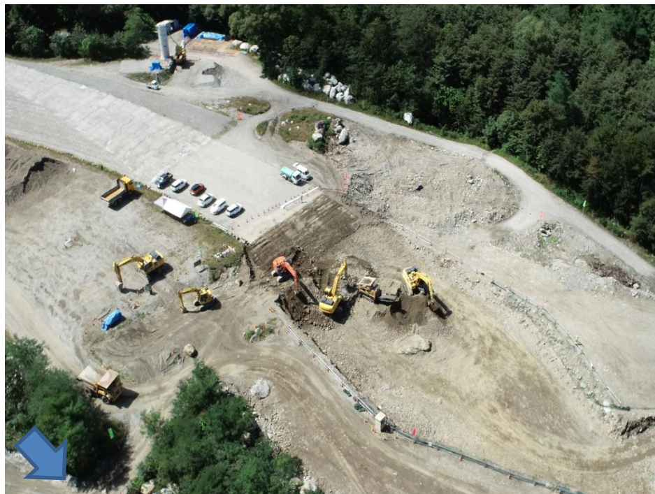
導流堤工 作業土工 床掘(掘削(砂防))
