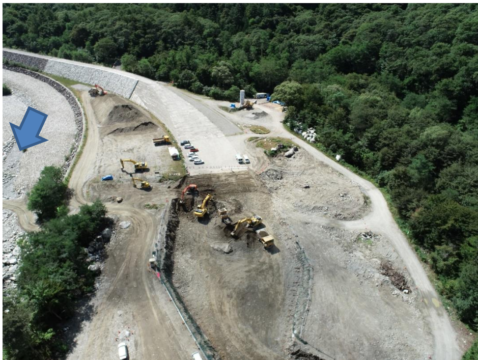
導流堤工 作業土工 床掘(掘削(砂防))
