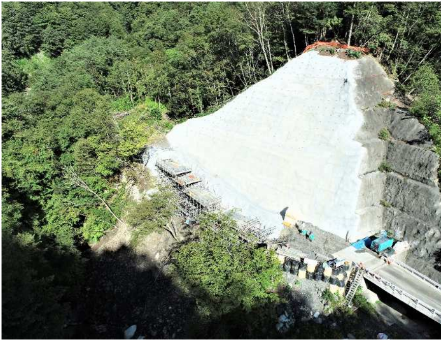
【下流側上空より施工箇所を望む】
