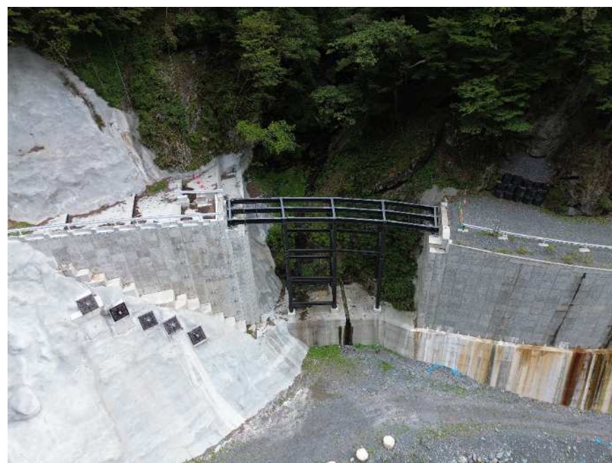
【上空より上部工施工箇所を望む】
