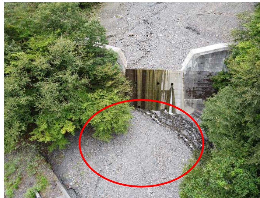
小春木着工前（赤予定箇所）
