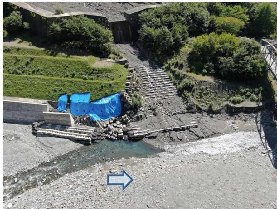
【右岸側上空より施工箇所を望む】
