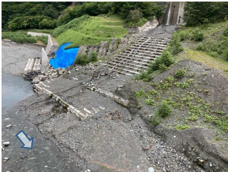
【下流側上空より施工箇所を望む】
