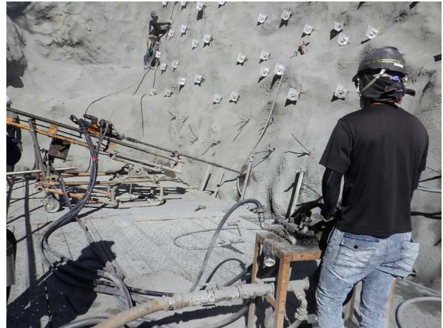
【鉄筋挿入工施工状況】
