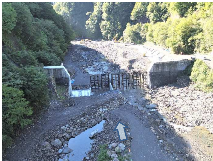
【上流側上空より施工箇所を望む】
