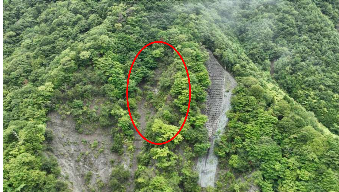
着工前近景（赤予定箇所）
