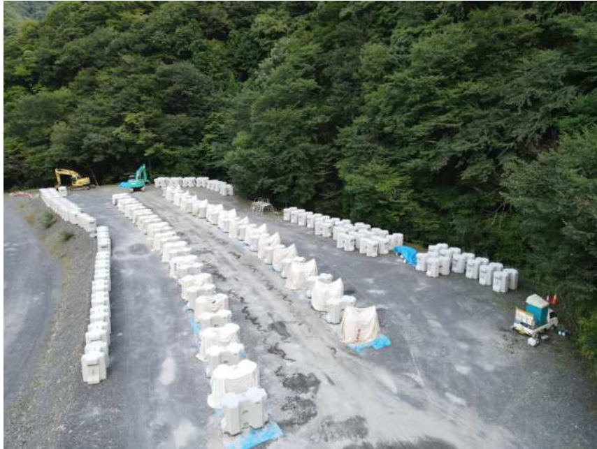
根固ブロック製作中
