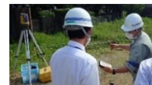
トータルステーション計測
