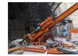
ダウンザホールハンマー削孔
