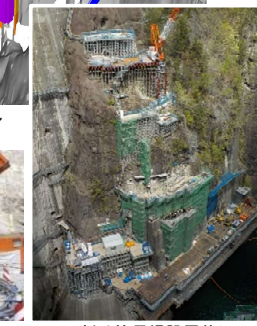
削孔等足場設置状況
