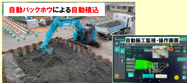
R3霞ヶ浦導水石岡トンネル(第3工区)新設工事(イメージ)
