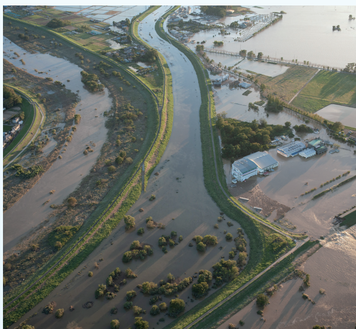
令和元年東日本台風の被害。越辺川(右下)の右岸堤防が決壊(川越市平塚新田地先)
