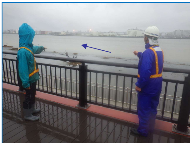
多摩川左岸0.0k 多摩川スカイブリッジ下流
