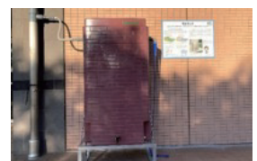
雨水貯留タンクの設置 (京浜河川事務所)
