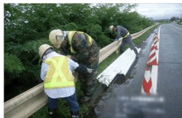
<防護柵の取替>
